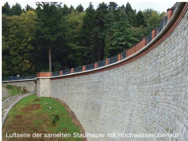
Luftseite der sanierten Staumauer mit Hochwasserüberlauf
